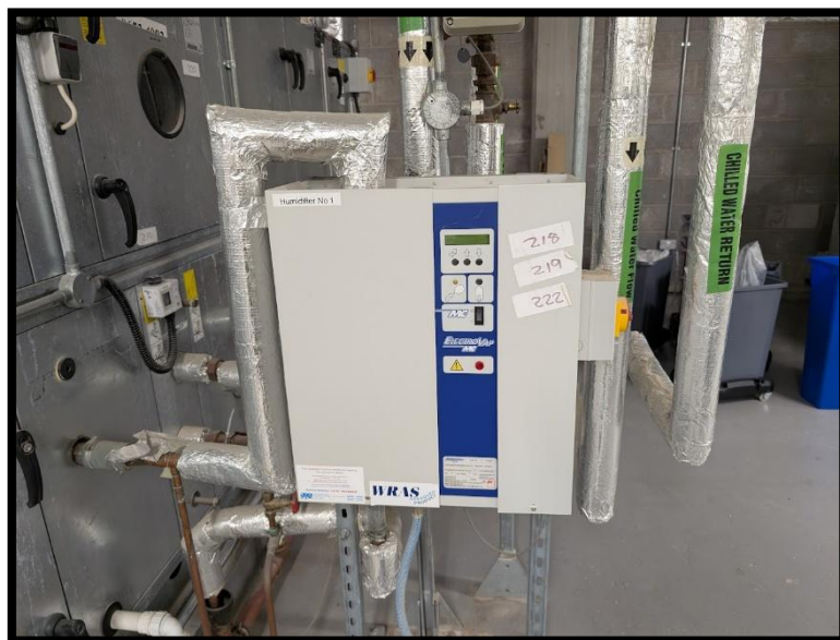
Redundant humidifier
